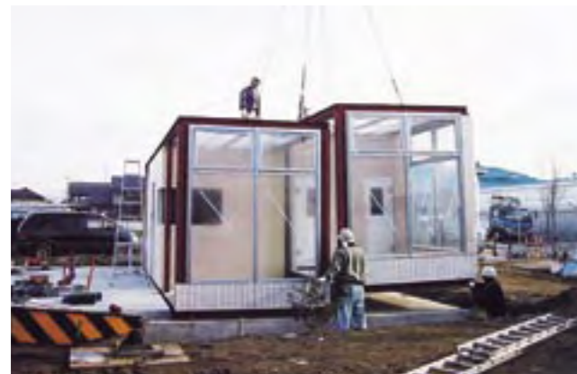
エコロユニットの組み立て作業の様子
