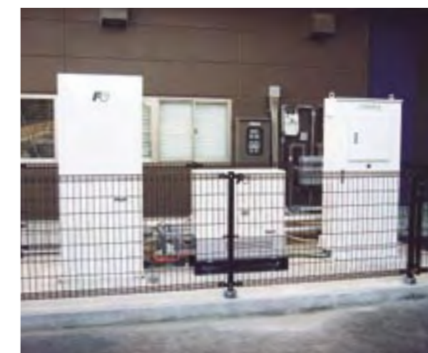
伊都キャンパス内に設置された固体高分子形燃料電池コージェネレーションシステム
